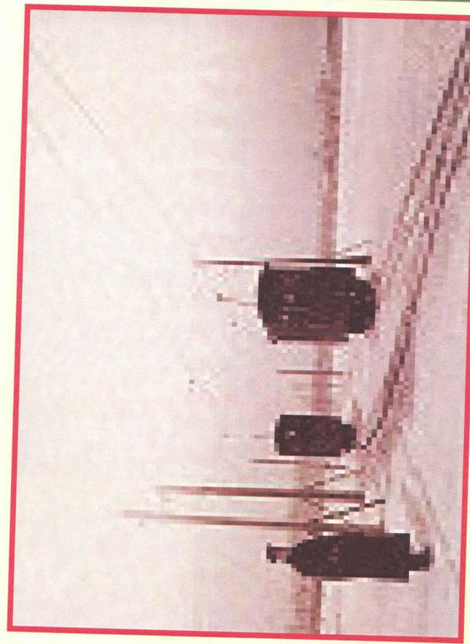
Рельсы и шпалы укладывались просто на ледяную поверхность, а столбы для проводов вмораживались в лёд.
